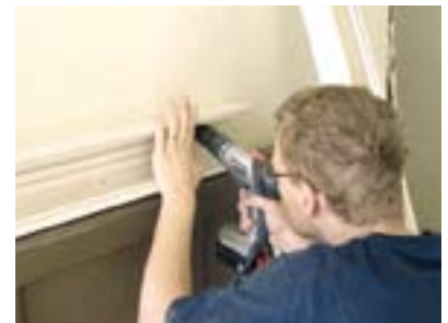
Beim Innenausbau des Cafés
